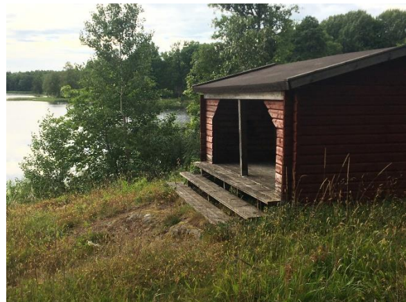
Vindskyddet som byggdes vid badplatsen. Ett led i arbetet med Trehörna framtidsplan.
