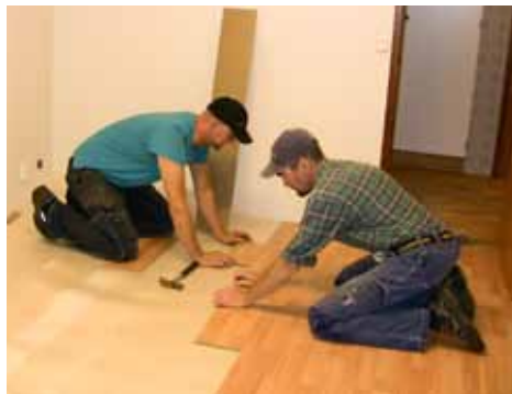
Magnus Oscarsson och Mikael Brickarp lägger nytt golv i nya Solgläntan
